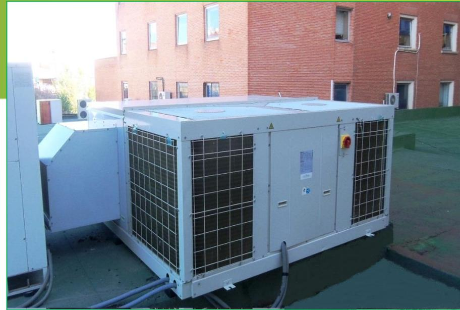
**nueva bomba de calor de alta eficiencia instalada**
