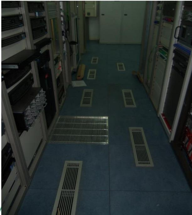
**rejillas instaladas en suelo técnico del CPD (RES-12)**
